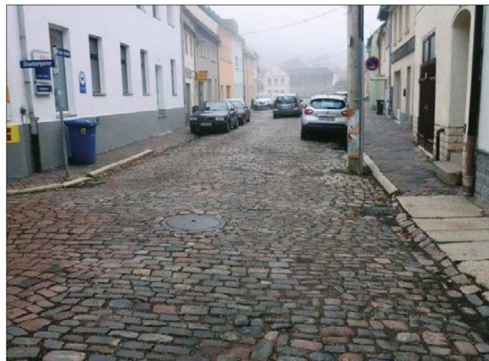
Breite Straße vor dem Ausbau, Foto: Archiv
