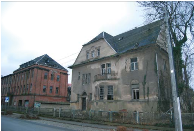
November 2021: der Abriss hat begonnen, bald sind auch diese Brachen nicht mehr zu sehen.
