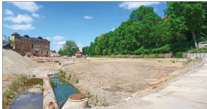
Rückbau Mühlgraben und Anlage eines Regenwasserkanals, Juni 2022
