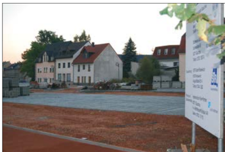
Parkplatz Hoffnung während der Bauarbeiten Ende September 2013, Foto: Stadt Glauchau
