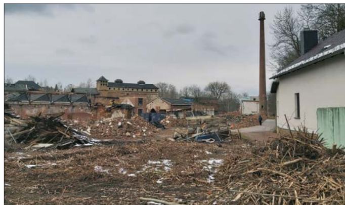
März 2021: Abbruch der Bausubstanz am ehem. FGW-Gelände, im Mai wurde der Schornstein gesprengt.
